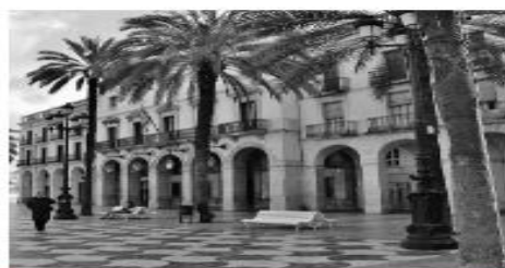
PROV. OF BARCELONA / VILANOVA I LA GELTRU Spain
