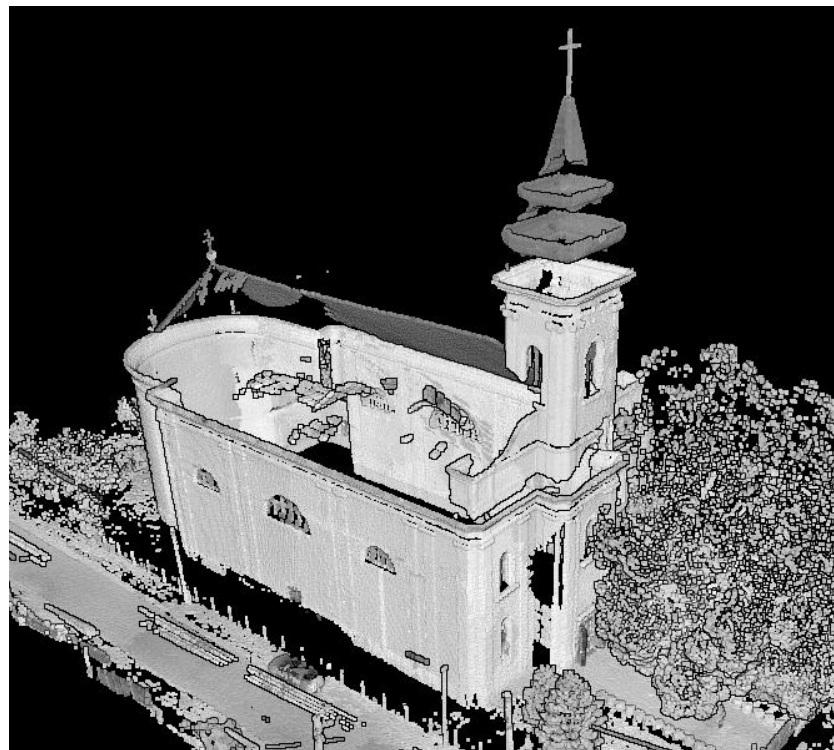
Pozemné laserové skenovanie exteriér
